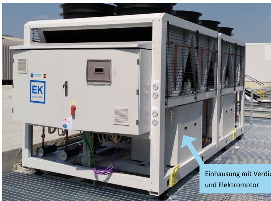
Abbildung 7.0.03: Luft/Wasser-Wärmepumpe mit eingebautem Verdichter. Teilweise gekapselte Luft/ Wasser-Wärmepumpe mit eingehaustem Verdichter
