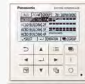
Zentrale Bedienstation mit integriertem Programmtimer
